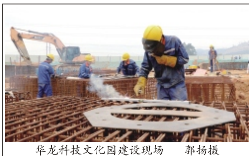
华龙科技文化园建设现场 郭扬摄
