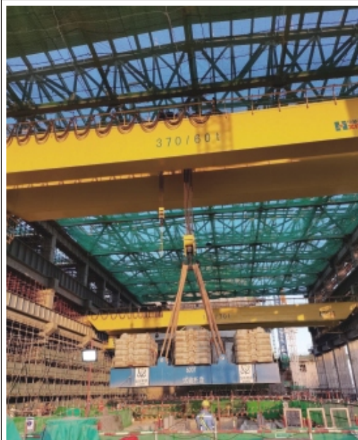
“华龙一号”漳州核电1号机组常规岛两台主行车载荷试验顺利完成
