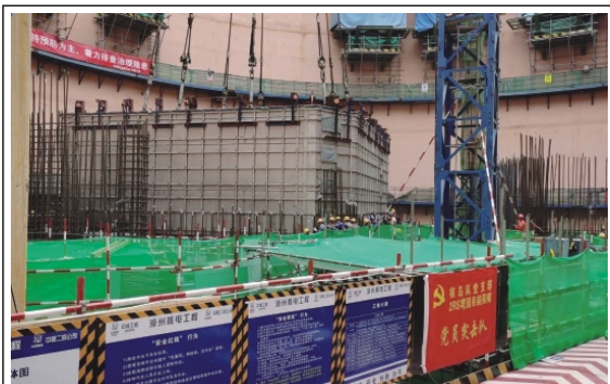
“华龙一号”漳州核电2号反应堆厂房非能动堆腔注水箱池壁模块吊装完成
