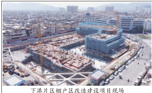
下港片区棚户区改造建设项目现场
