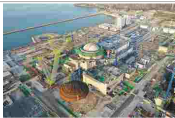
2月17日，我国自主研发的三代核电“华龙一号”批量化建设首台机组外穹顶成功吊装。漳州能源供图
