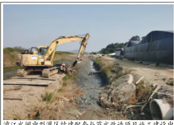
漳江水闸中型灌区续建配套与节水改造项目施工建设中
