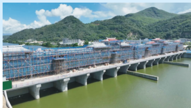
东厦镇北江水闸提升改造工程施工现场
