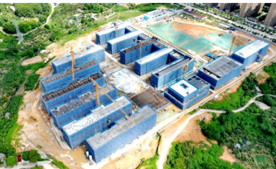
云霄一中新校区迁建项目主体结构全面封顶
