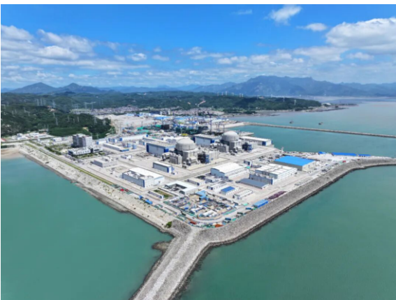
漳州核电项目建设如火如荼 方伟文 摄
