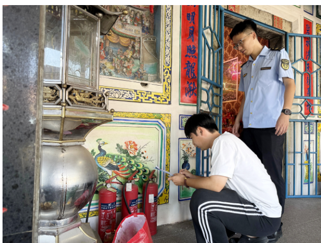
工作组检查消防设施配备
