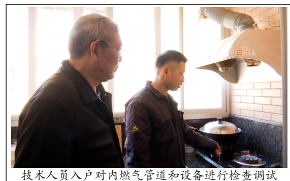
技术人员入户对内燃气管道和设备进行检查调试
