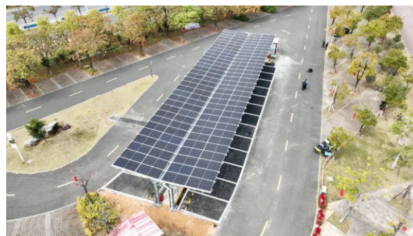
新能源汽车充电站施工现场
