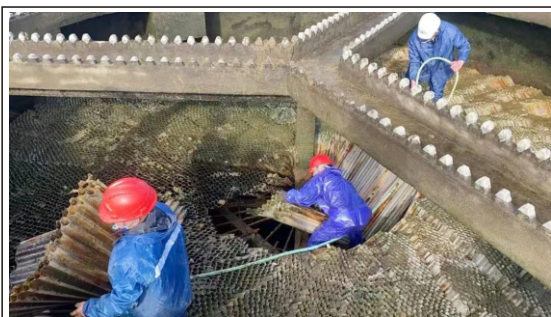
云霄水务公司工程部技术人员对厂区供水系统现场巡检
