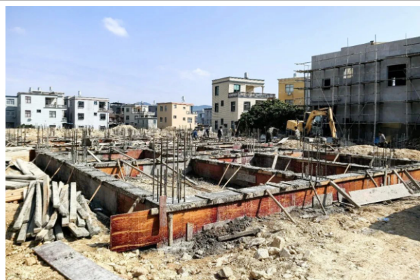
竹港村南片东埔新村项目建设现场
