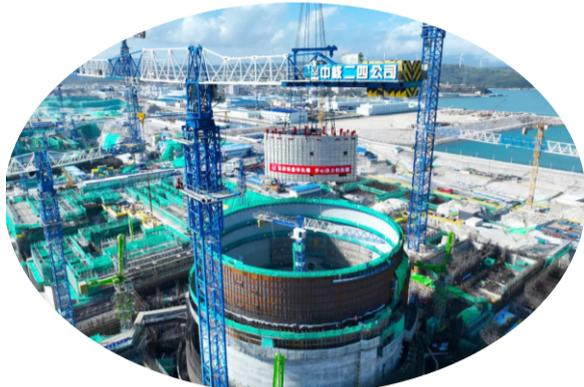
“华龙一号”漳州核电3号机组核岛反应堆厂房非能动堆腔注水箱模块一吊装成功
