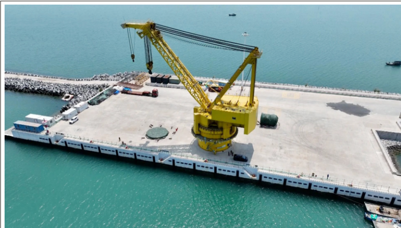
重件码头航拍图
